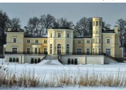
Pałac w Łącku. Fot. z arch. LGD AKTYWNI RAZEM
