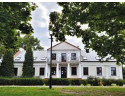
Dwór w Brudzeniu Dużym. Fot. IK
