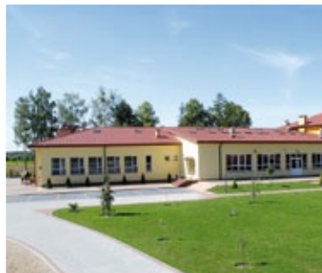
Budynek Zielonej Szkoły po przeprowadzonym remoncie
