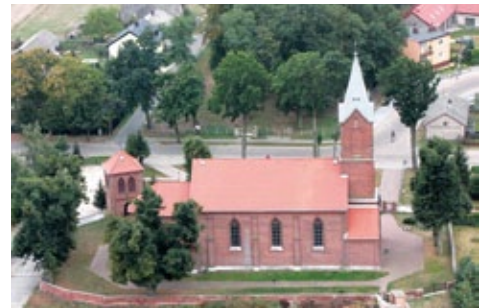
Kościół murowany neogotycki z 1881 r. p.w. Świętej Trójcy z dzwonnica w Kłótnie
